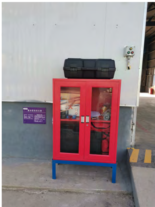
液氯罐区应急物资
