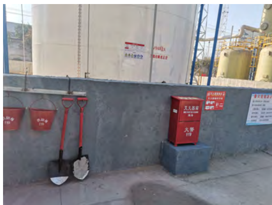
罐区应急物资
